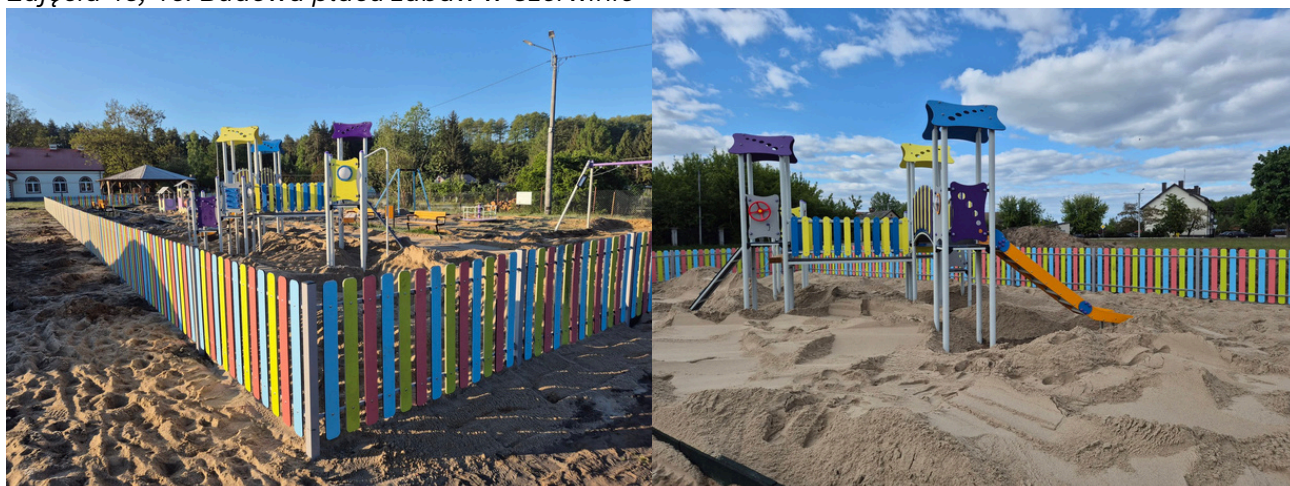
Zdjęcia 45, 46. Budowa placu zabaw w Czerwinie
