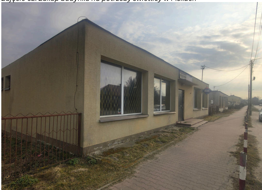
Zdjęcie 62. Zakup budynku na potrzeby świetlicy w Piskach
