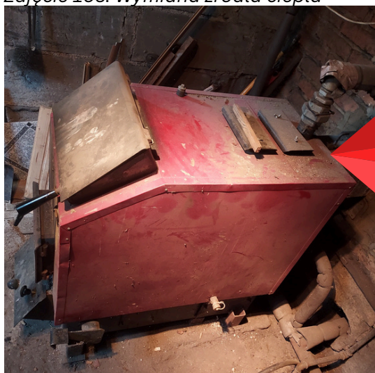
Zdjęcie 103. Wymiana źródła ciepła
