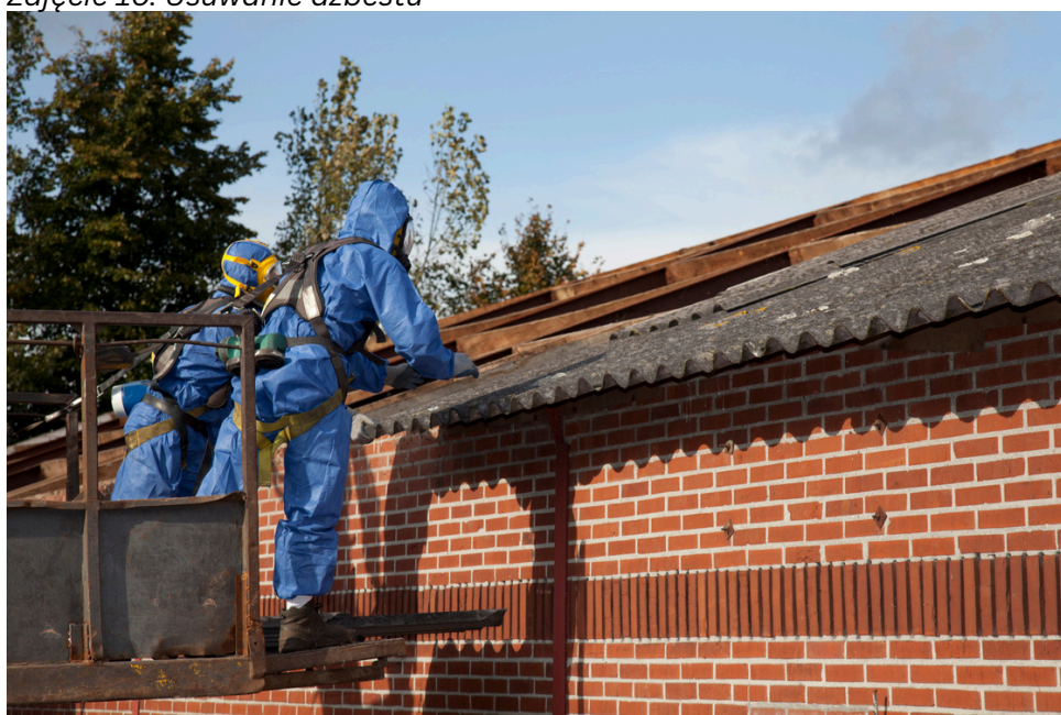
Zdjęcie 10. Usuwanie azbestu
