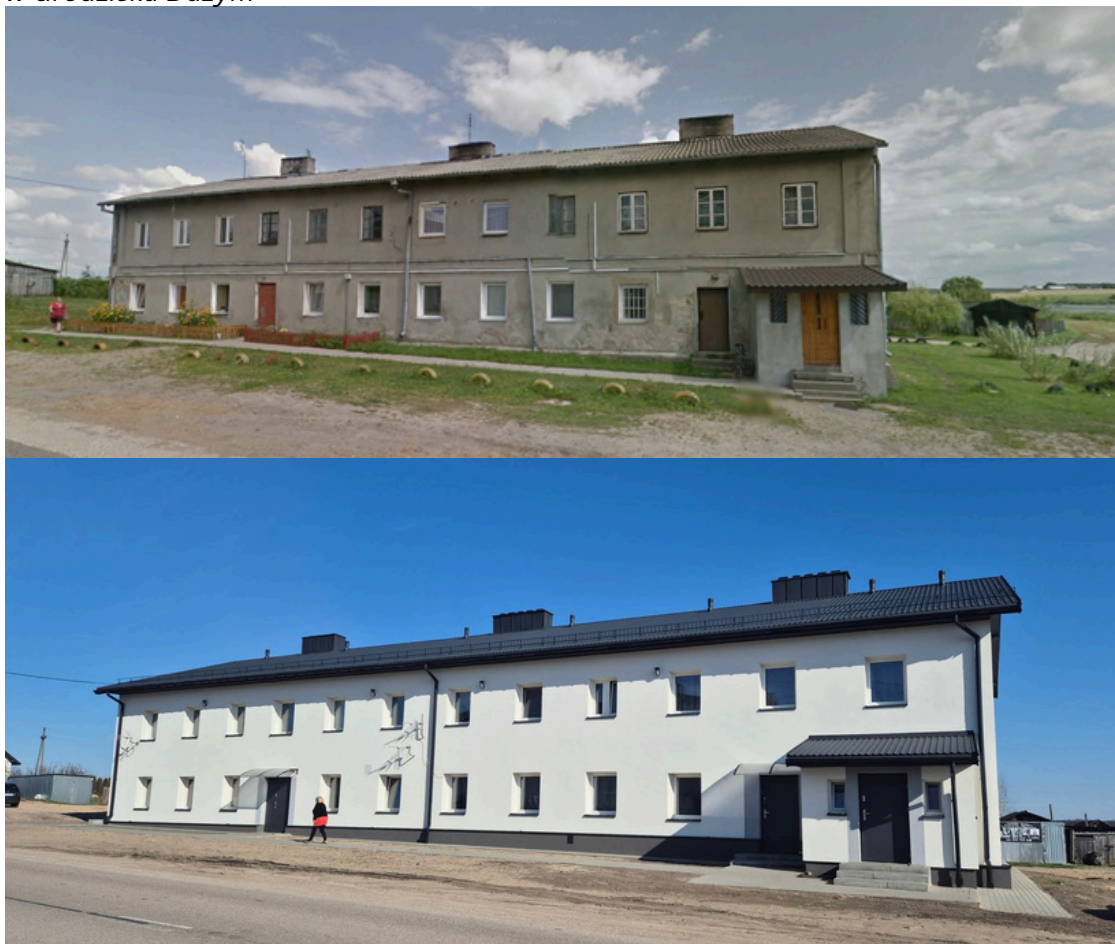
Zdjęcia 51, 52. Termomodernizacja wielorodzinnych budynków mieszkalnych w Grodzisku Dużym
