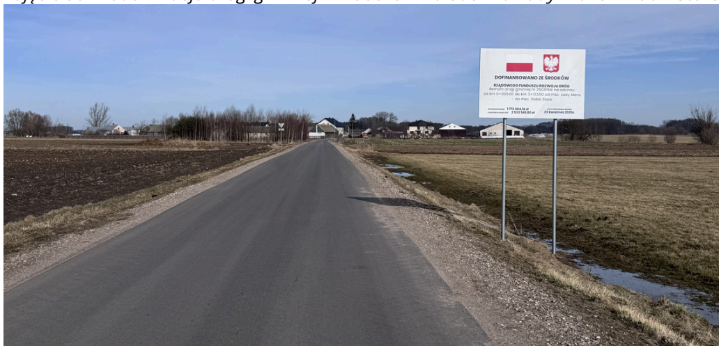
Zdjęcie 30. Modernizacja drogi gminnej nr 250319W na odcinku Łady-Mans – Dobki Stare
