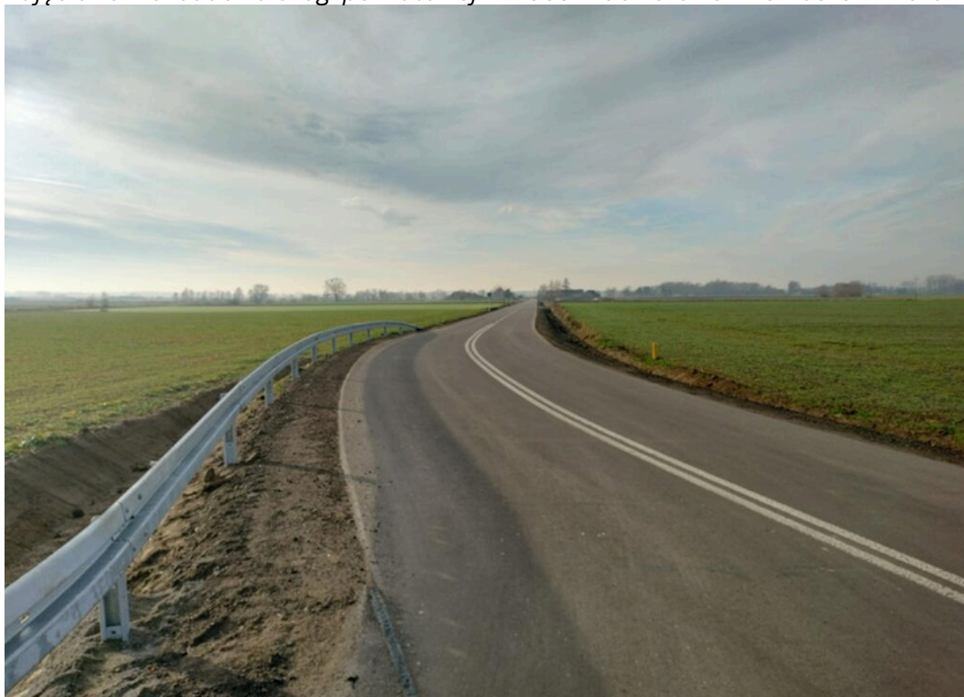
Zdjęcie 19. Rozbudowa drogi powiatowej nr 2568W Goworowo – Tomasze – Rzekuń
