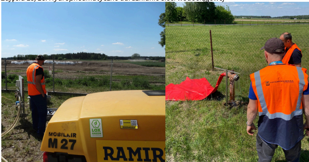
Zdjęcia 15, 16. Hydropneumatyczne udrażnianie sieci wodociągowej
