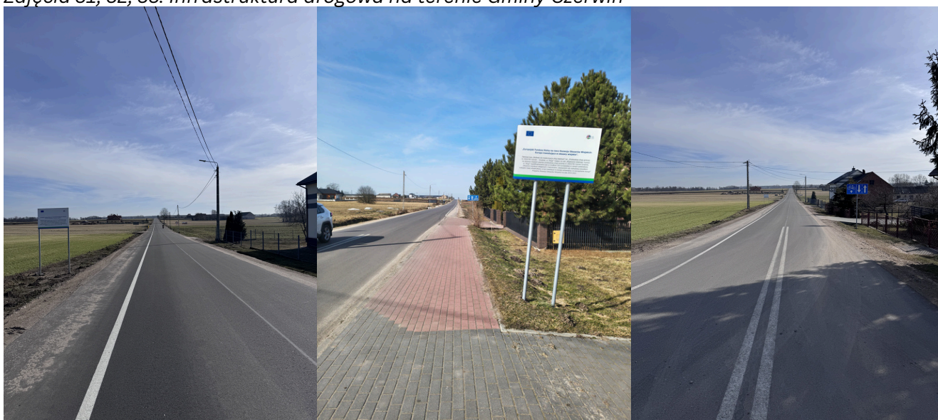
Zdjęcia 31, 32, 33. Infrastruktura drogowa na terenie Gminy Czerwin
