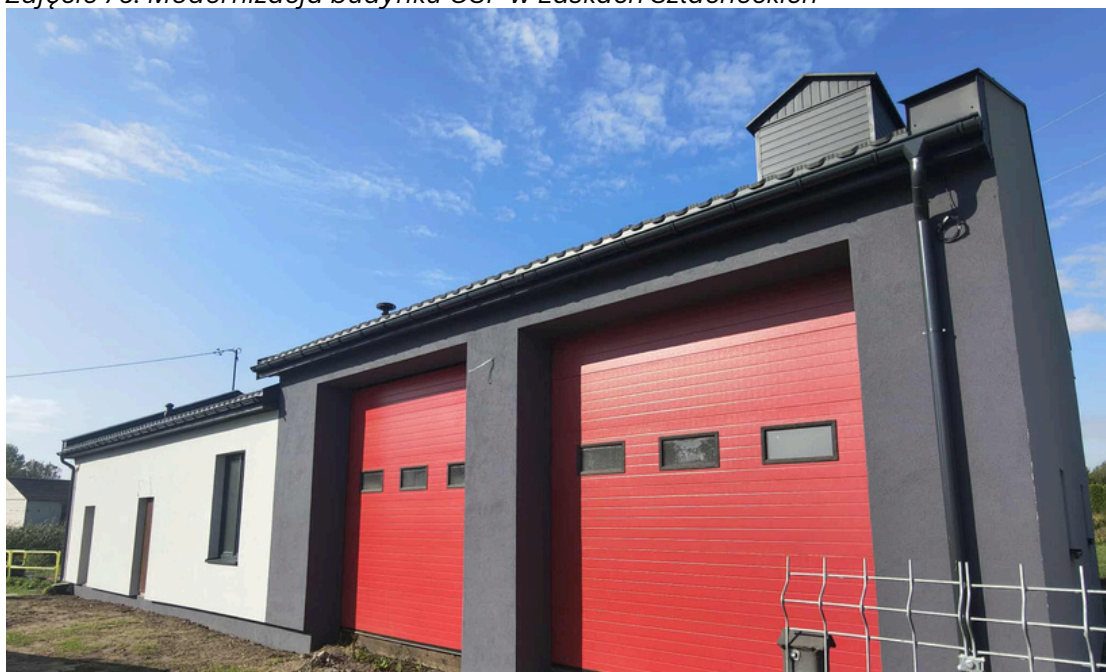
Zdjęcie 76. Modernizacja budynku OSP w Laskach Szlacheckich
