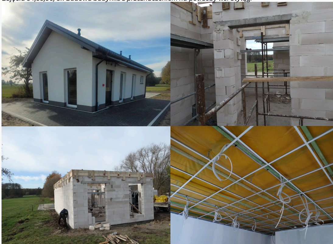
Zdjęcia 34,35,36, 37. Budowa budynku z przeznaczeniem na potrzeby wsi Stylagi
