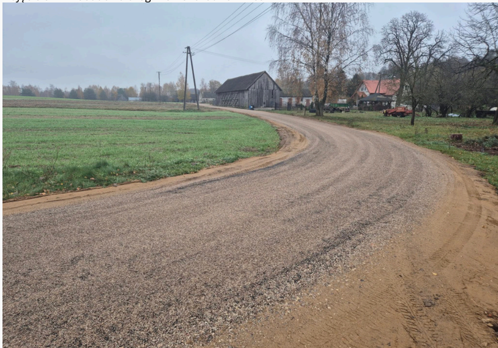
Zdjęcie 32. Przebudowa drogi we wsi Grodzisk-Wieś
