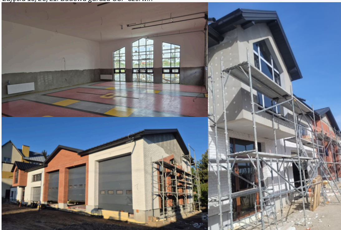
Zdjęcia 19, 20, 21. Budowa garażu OSP Czerwin
