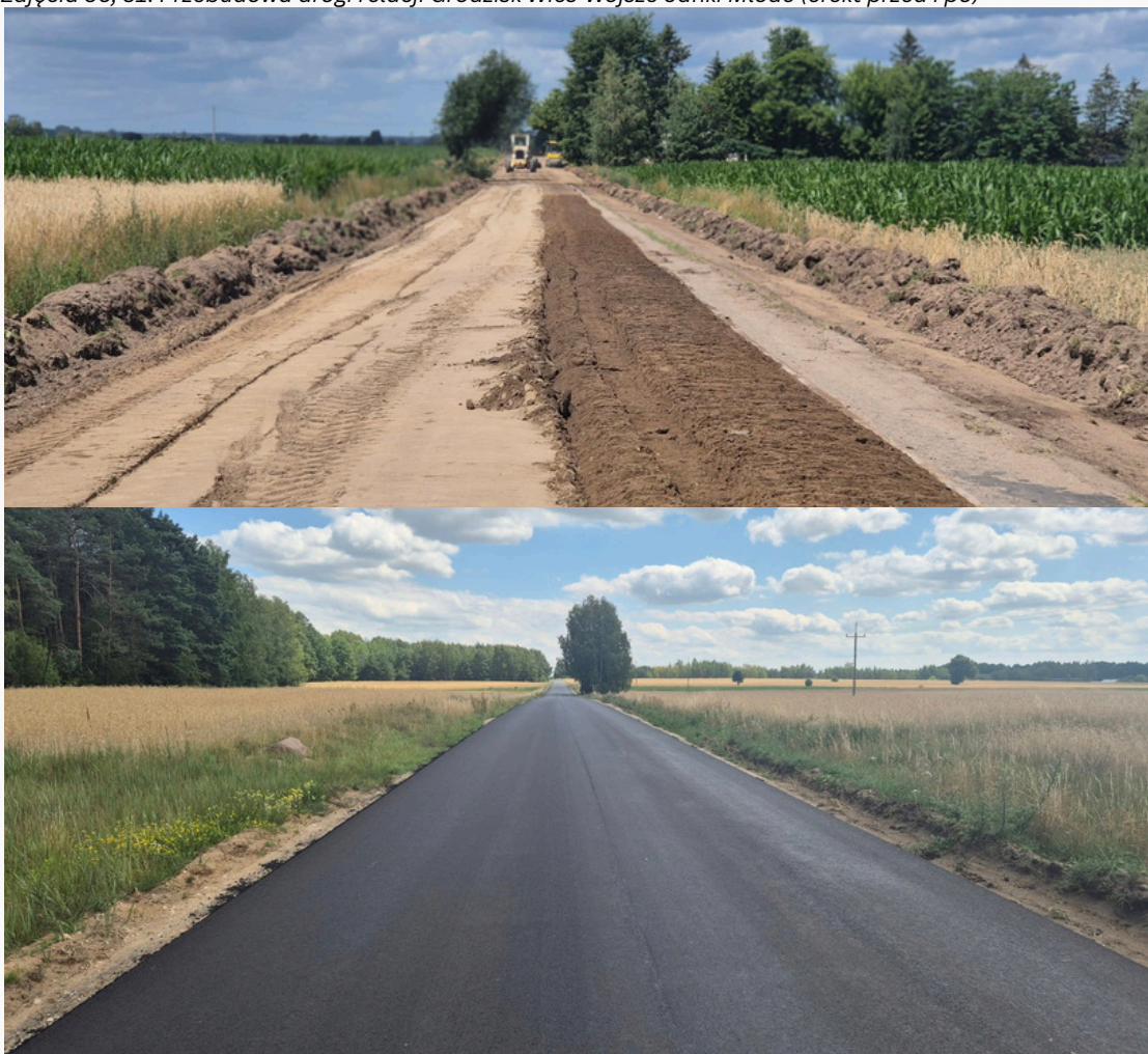
Zdjęcia 30, 31. Przebudowa drogi relacji Grodzisk Wieś-Wojsze-Janki Młode (efekt przed i po)
