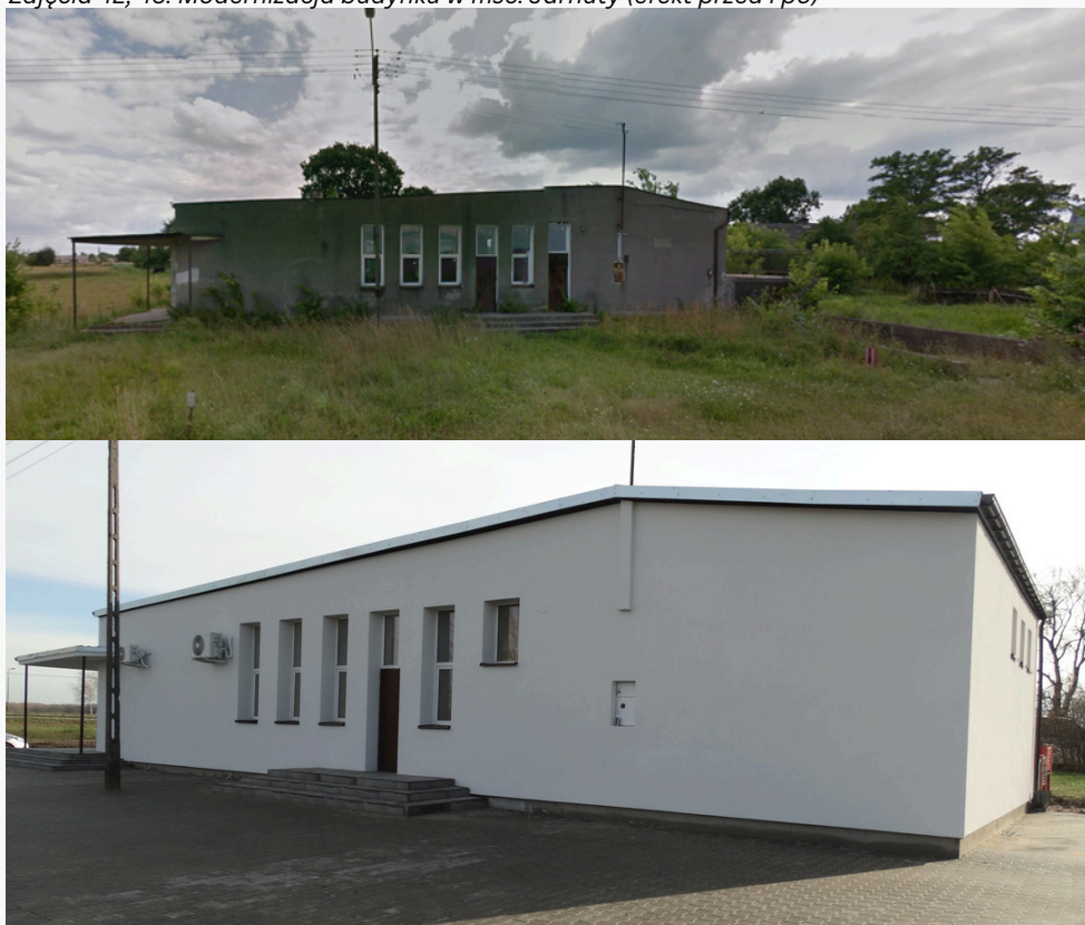
Zdjęcia 42, 43. Modernizacja budynku w msc. Jarnuty (efekt przed i po)
