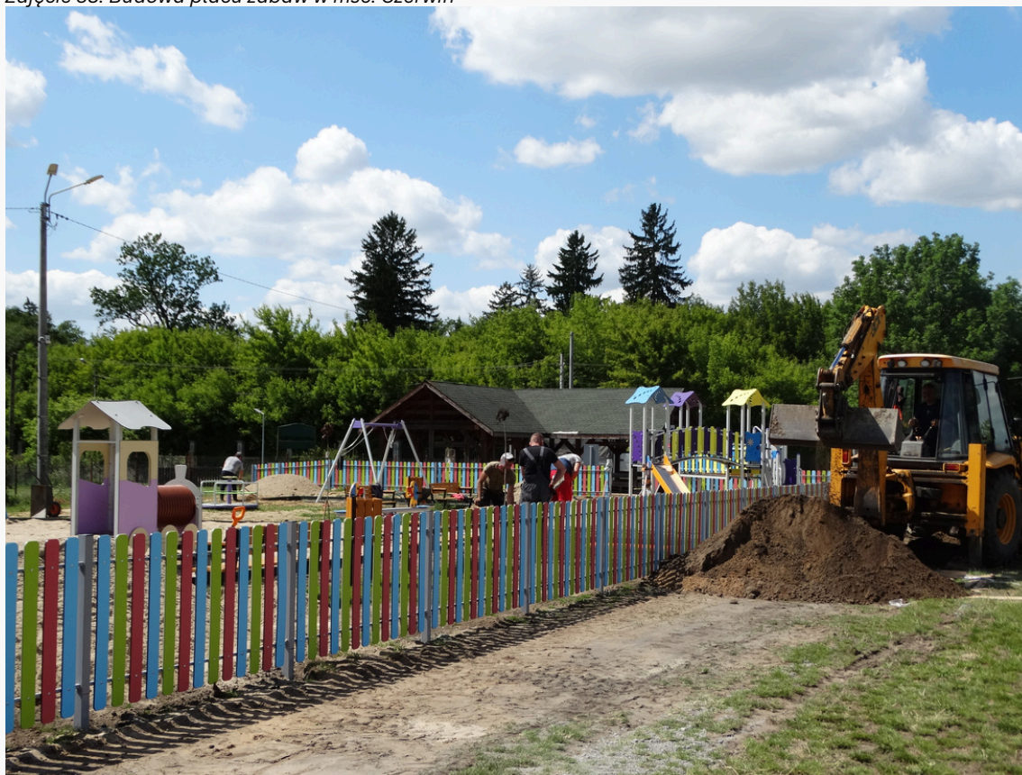
Zdjęcie 38. Budowa placu zabaw w msc. Czerwin
